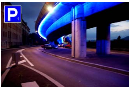
Sous l'autopont Avenue du TRICASTIN
